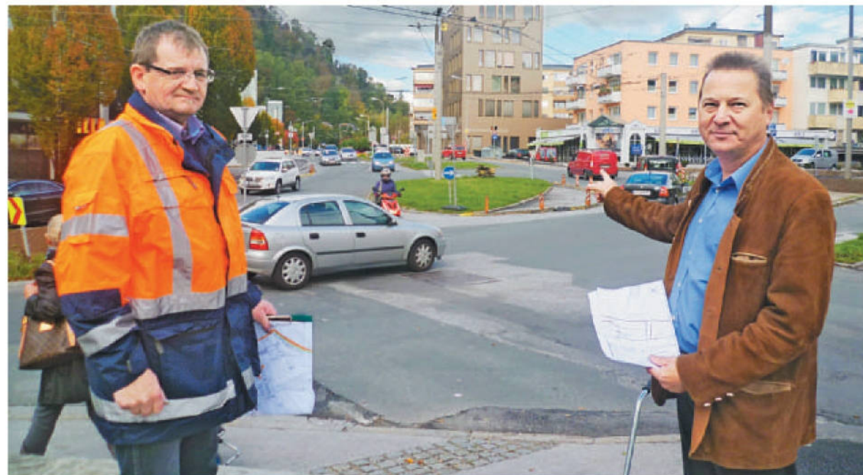
Die Eder-Kreuzung in Parsch wird ab November umgebaut. Tiefbaukoordinator Rupert Kübler (rechts) und ein weiterer Mitarbeiter der Stadt bereiten alles vor. Foto: S. Wenger
